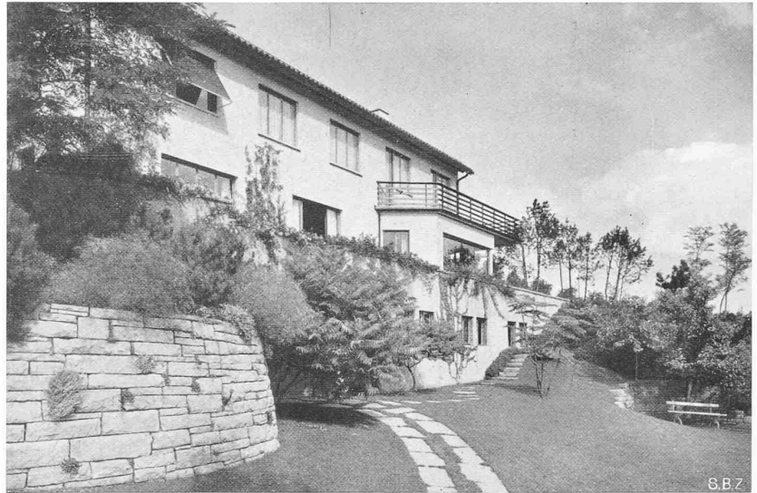
Abb. 7. Südwestfront, von der Auffahrt, aus Westen gesehen
