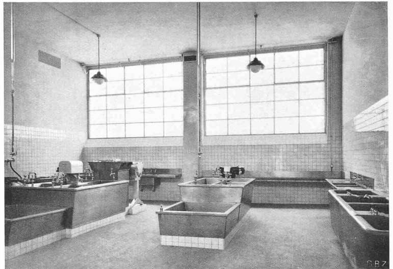
Abb. 17. Darmerei mit Trögen in Porphyr-Kunststein und Chromstahl
