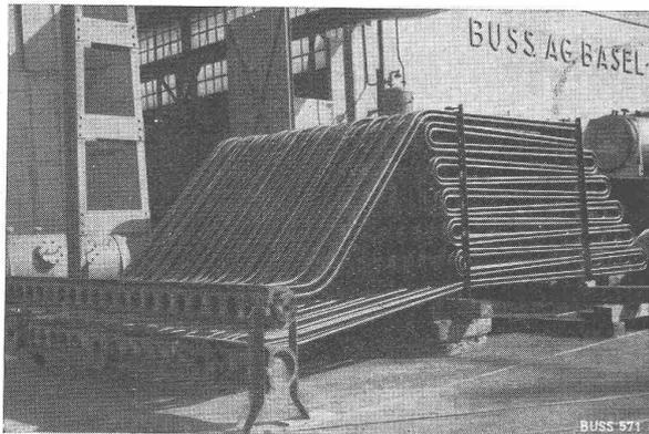
Ueberhitzer für einen Steilrohrkessel 500 m<sup>2</sup>, 34 Atü, 425° C Dampf-
