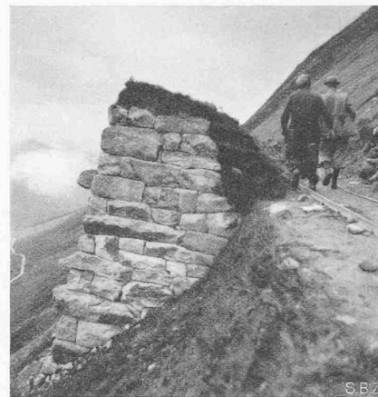
Abb. 1. Vorbildliche Trockenmauer als Lawinerverbauung an der Oberalp
