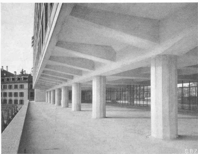
Abb. 14. Offene Erdgeschoss-Halle, links Dach der Lehrwerkstätten
