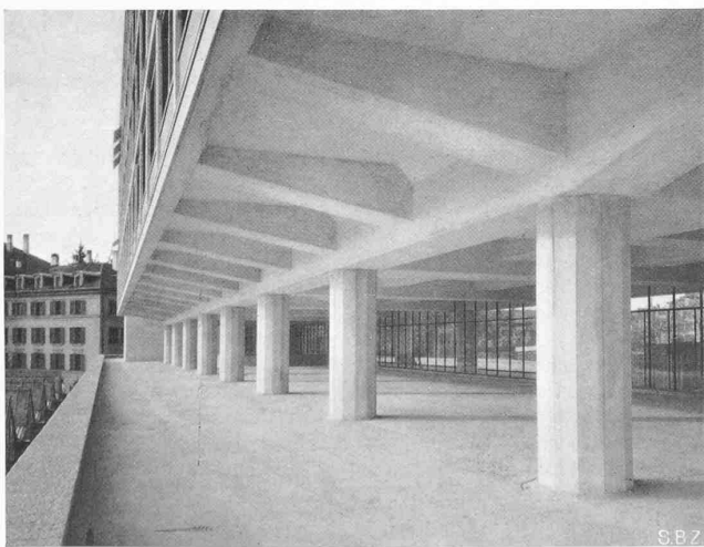
Abb. 14. Offene Erdgeschoss-Halle, links Dach der Lehrwerkstätten
