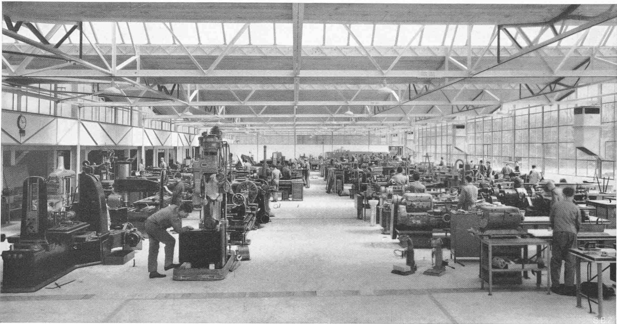
Abb. 18. Gesamtbild der Lehrwerkstätten. — Eisenkonstruktion von Ing. WALTHER TOBLER, Bern
