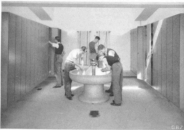
Abb. 19. Garderobe- und Wasch-Koje neben der Werkstatthalle
