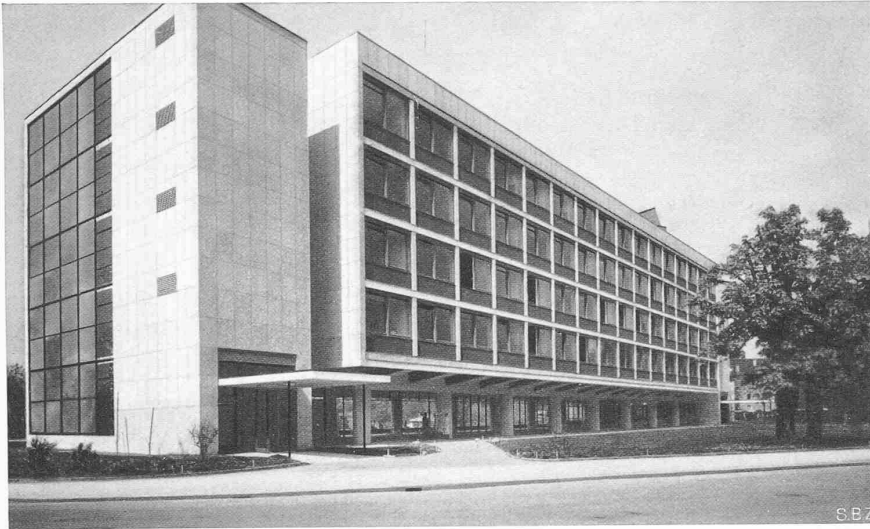
Abb. 4. Ansicht aus Osten, von der Lorrainestrasse aus NB. Der in Abb. 5 sichtbare Einschnitt für die Zufahrtstrasse zu den Lehrwerkstätten wird später verschwinden (vgl. Lageplan auf Seite 221)
