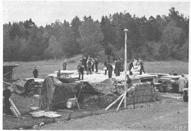
Aufbau eines schwedischen Bauelemente-Kleinhauses in 10 1/2 Stunden
