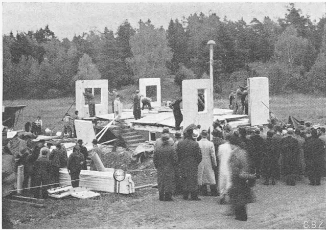
Abb. 9. 9 h: Die Wandblöcke werden aufgestellt
