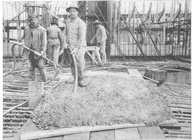
Abb. 5 und 6. Rüttelversuch an 1 m 3 Beton P 250 (Setzmass 1 bis 1,5 cm, Ausbreitmass 25 bis 30 cm). Durch Rütteln während 1/2 min hat sich die erdfuchte Konsistenz (links) in die plastische (rechts) umgewandelt
