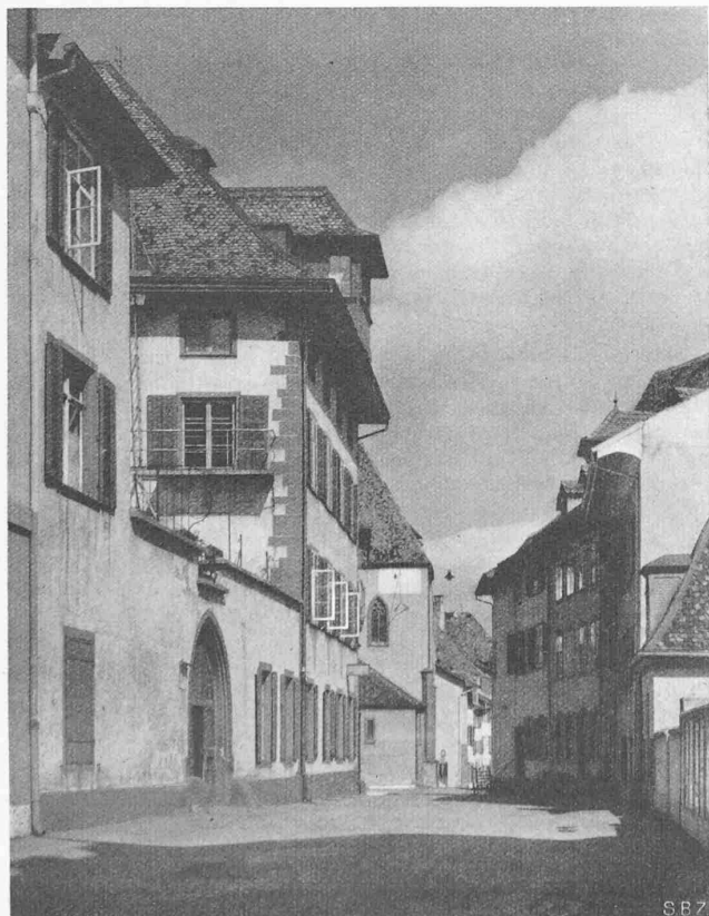
Abb. 5. Der Engelhof am Nadelberg, gegen die Petersgasse
