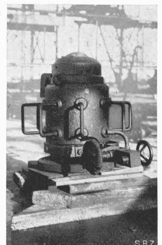
Abb. 18. Seitenpresse mit Griffen zum Verschrauben
