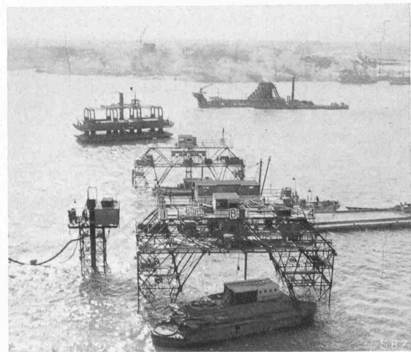
Abb. 21. Links neben den Richttürmen der Spülturm Bauausführung der Fluss-Strecke beim Autotunnel unter der Maas in Rotterdam
