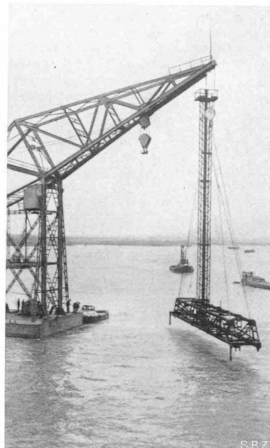
Abb. 15. Messgerät zur Kontrolle der genauen Lage der Lagerbalken. Das im Turm eingebaute Rohr dient dem Hochloten des elektrisch beleuchteten Axpunktes mittels optischem Lot
