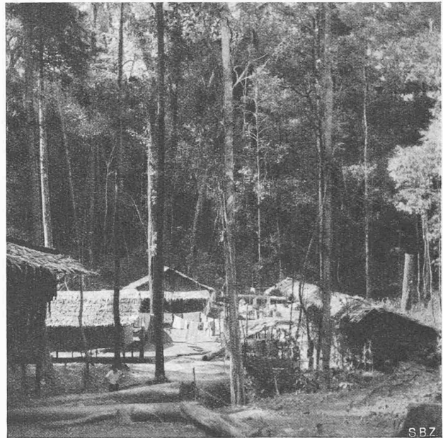
Abb. 3. Typisches Arbeitslager im Urwald, aus am Ort geschlagenem Rundholz und Palmblättern
