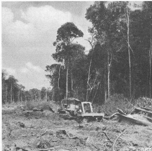
Abb. 4. Säuberung des gerodeten Tracéstreifens von Wurzelholz u. dgl. mittels des «Rooter»
