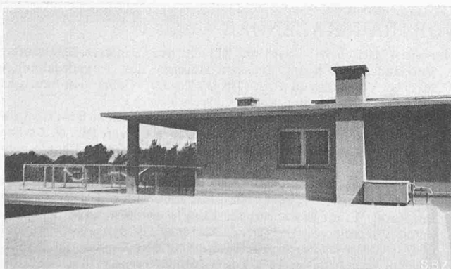
Abb. 13. Dach, links die «Sommerterrasse», im Hintergrund die Wüste
