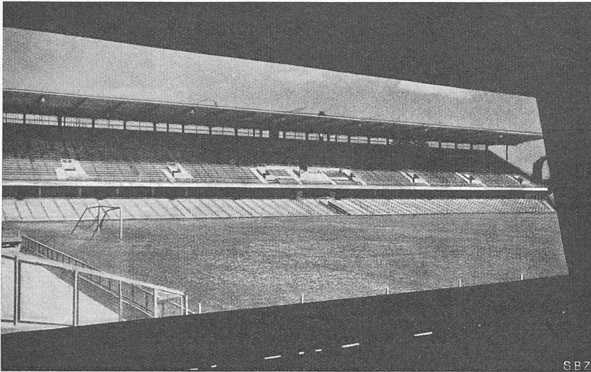
Abb. 2. Blick auf die Haupttribüne, vom unteren Promenadengang der Westtribüne aus
