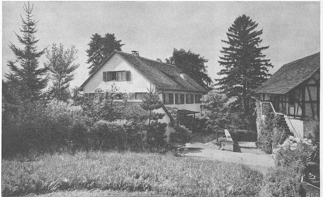
Abb. 1. Wohnhaus Sch.-E. aus Nordosten, von der Zugangsseite, rechts die alte Trotte
