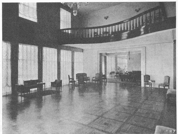
Abb. 14. Festsaal mit Galerie, gegen Speisesaal und Wintergarten Ost
