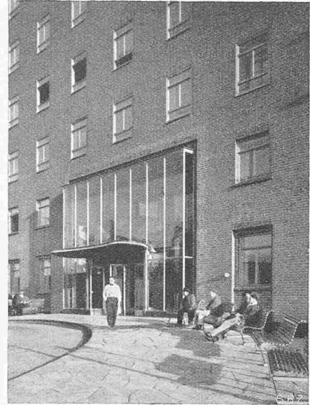
Abb. 5. Haupteingang an der Nordseite
