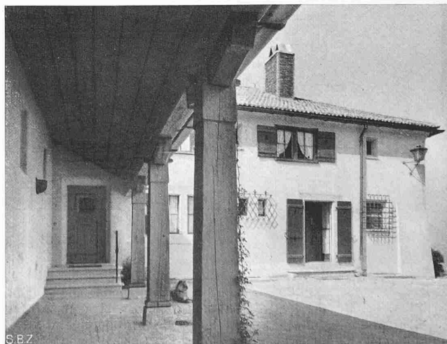
Abb. 4. Blick von der Garage gegen Haupt- und Nebeneingang
