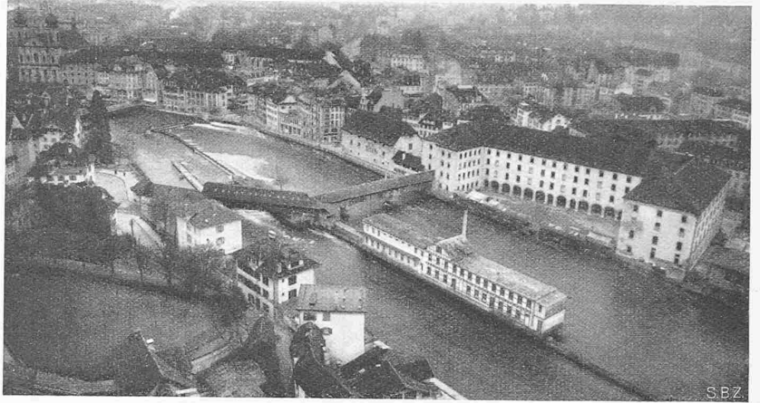
Abb. 2. Spreuerbrücke und alte Kaserne, aus Norden gesehen
