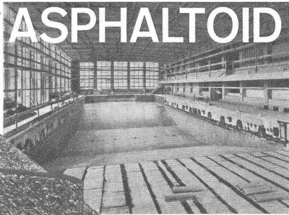
die elastische Isolierplatte mit imprägn. Gewebeeinlage
