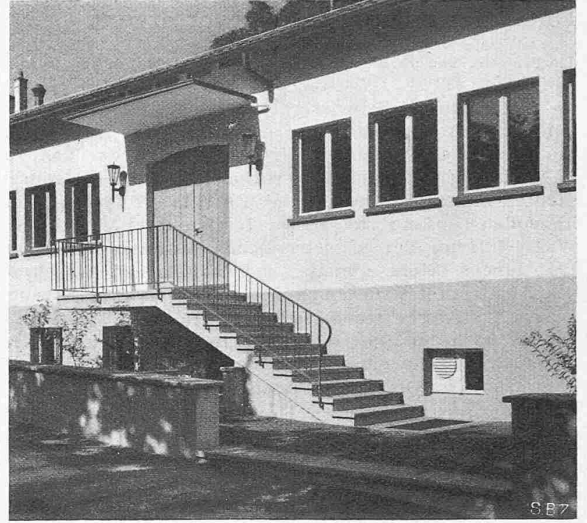
Abb. 3. Aussenzugang zum Saal
