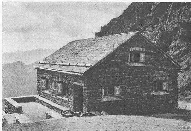
Die Medelserhütte des S. A. C., 2540 m ü. M., erbaut 1933
