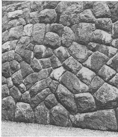
Abb. 8. Schlechte Zyklopenmauer aus braunem Numulitenkalk zusammengewürfelt
