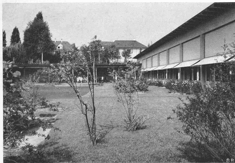
Abb. 5. Kindergarten des Bruderholz-Schulhauses in Basel
