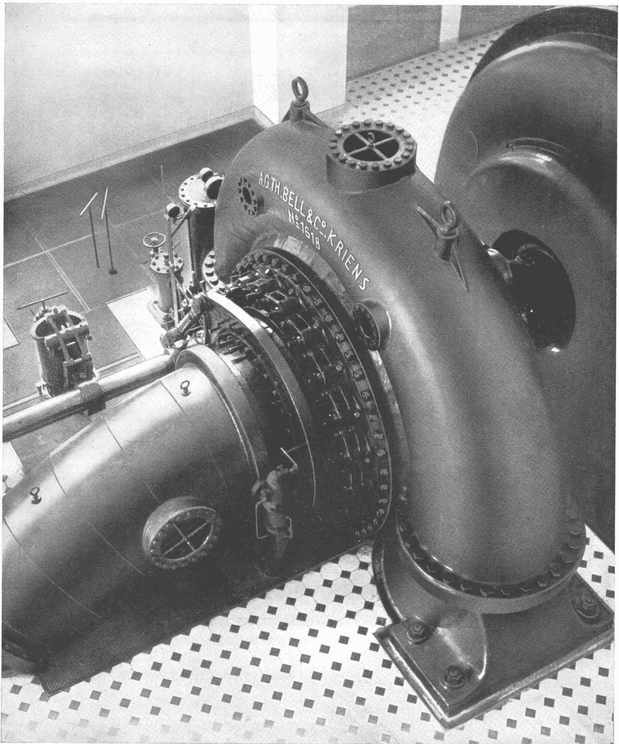
Eine der beiden durch die AG. der Maschinenfabrik von Th. Bell & Co., Kriens-Luzern gelieferten 22 750 PS-Francissturbinen des Elektrizitätswerkes Unteraa der Centralschweizerischen Kraftwerke AG.
