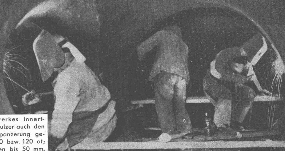
Verteilleitung des Kraftwerkes Innerschichten, für das Gebrüder Sulzer auch den Hochdruckteil der Schachtpanzerung geliefert haben. Prüfdruck 100 bzw. 120 at; Rohre gegläht; Wanddicken bis 50 mm.
