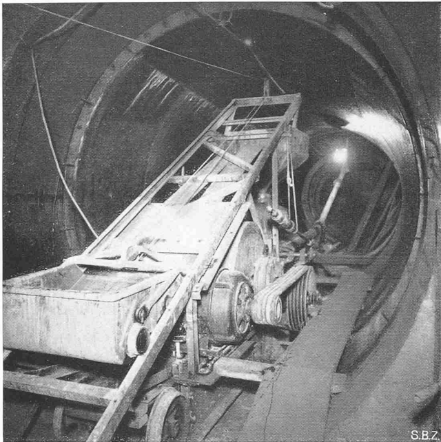
Abb. 13. Betonpumpe, links der Betonaufzugkübel, der in den Einfülltrichter der Pumpe (Hintergrund) kippt. Unter dem Aufzuggeleise der 30 PS-Antriebmotor der Pumpe, die bis 7 m 3 /h in die abgehende Leitung fördert
