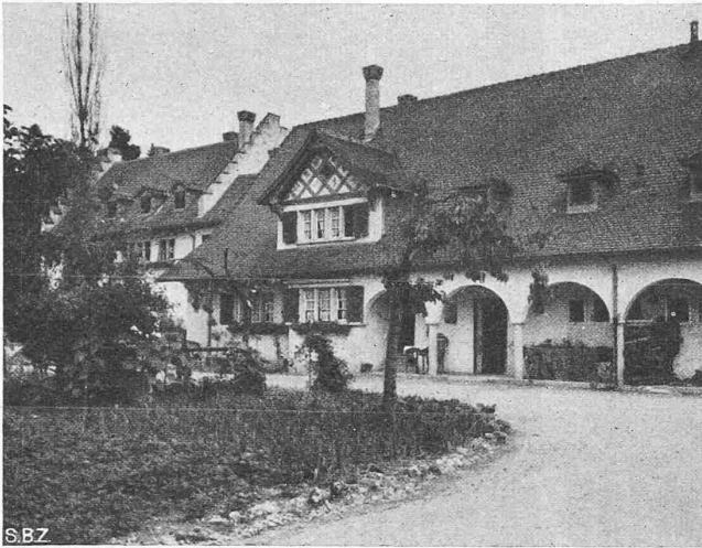
Abb. 11. Haus Typ A, links davon der Verwaltungsbau
