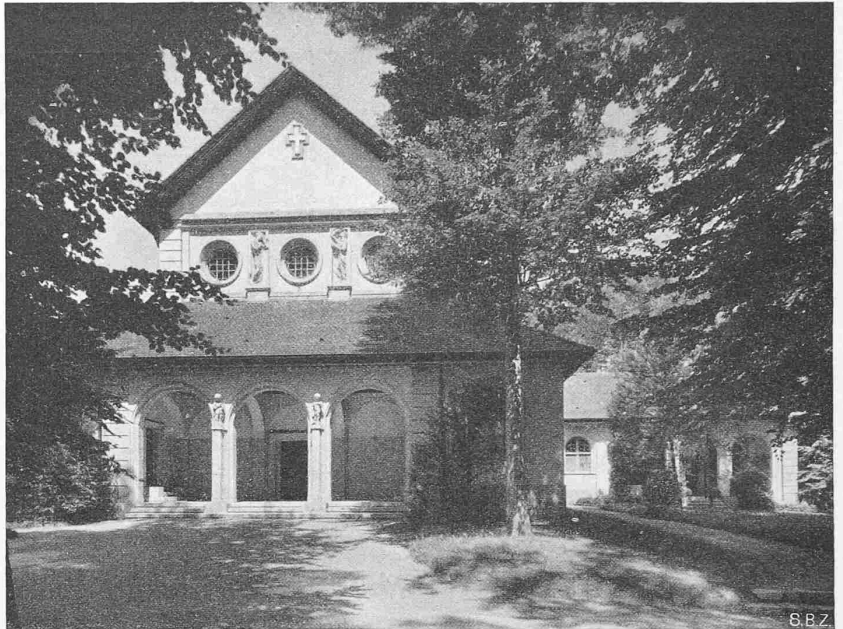
Abb. 1. Krematorium im Waldfriedhof Schaffhausen. Erbaut 1914 durch Carl Werner, Arch.
