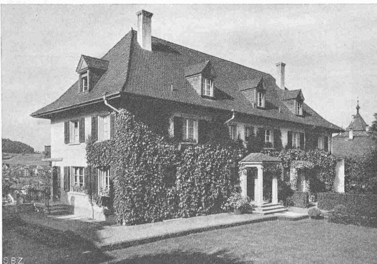
Abb. 6. Rückseite des Doppelwohnhauses Fehr (1929)
