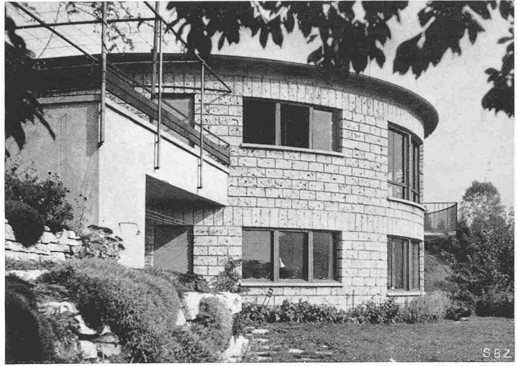
Abb. 2. Ansicht aus Westen, in Untergeschoss-Höhe
