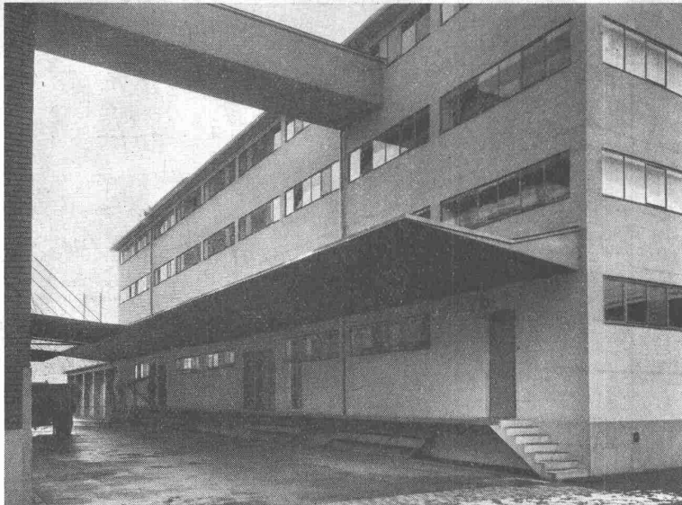
Lagerhaus der M. S. K. am Sihlquai in Zürich
