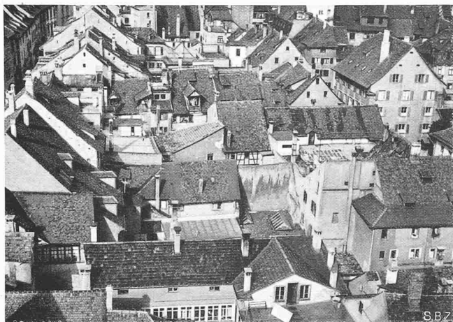
Abb. 3. Verbauung der Höfe zwischen der Vordergasse (links) und der Stadthausgasse, vom St. Johannsturm gegen Westen
