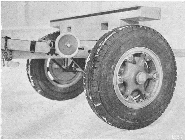
Abb. 5. «Trilex»-Rad +GF+ in Stahlguss oder Leichtmetall
