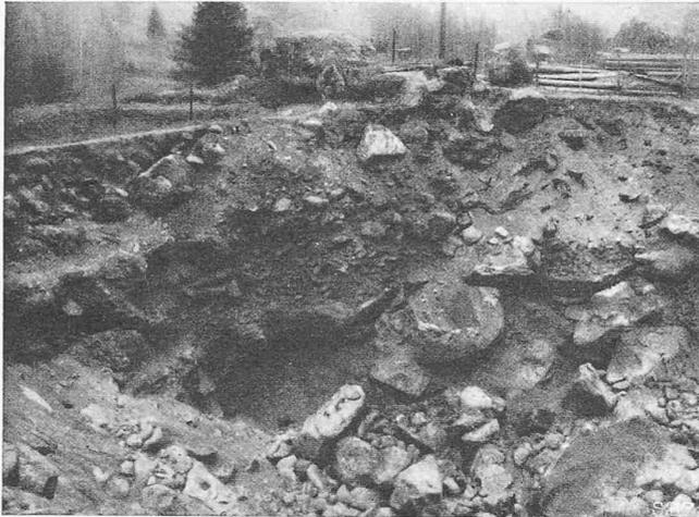
Abb. 1. Tagbruch-Trichter über dem Umlauf-Tunnel
