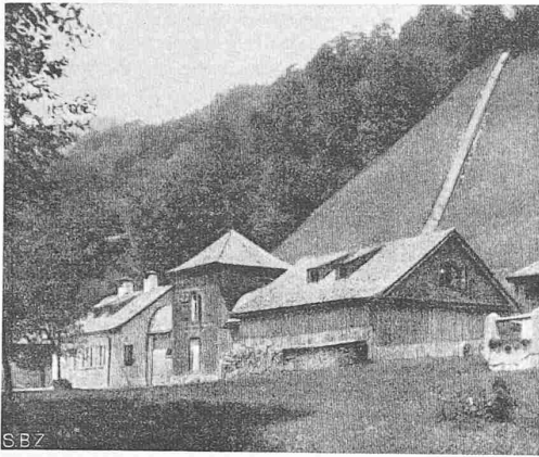
Abb. 4. Brunnhaus in Illsank bei Berchtesgaden mit Druckleitung auf 356 m Höhenunterschied
