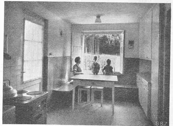
Abb. 7. Wohnküche, gegen das Gartenfenster
