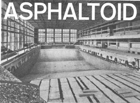
die elastische Isolierplatte mit imprägn. Gewebeeinlage
