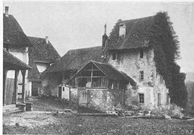
Abb. 1. Ehemaliger Zustand des Schösschens Altenburg
