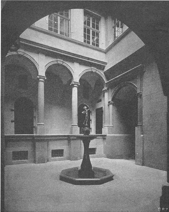
Abb. 11. Renaissance-Hof zwischen Rathaus und Staatskanzlei
