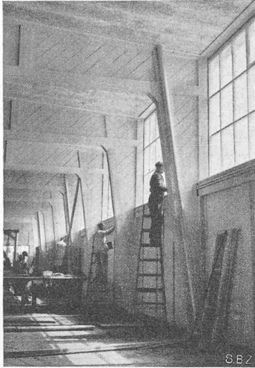
Abb. 5. Die Halle im Ausbau
