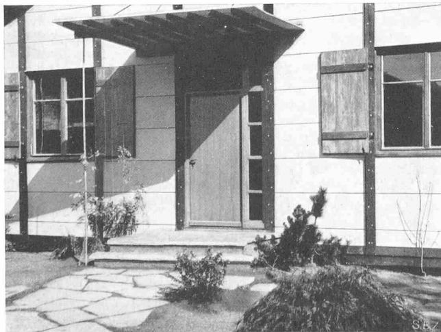
Abb. 19. Eingangstür zum Verwalter-Wohnhaus
