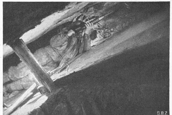
Abb. 17. Braunkohlen-Abbau, La Mionnaz (St. Martin), Fribourg
