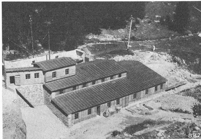
Abb. 16. Aufbereitungsanlage der Kupfergrube Grimentz im Val d'Anniviers
