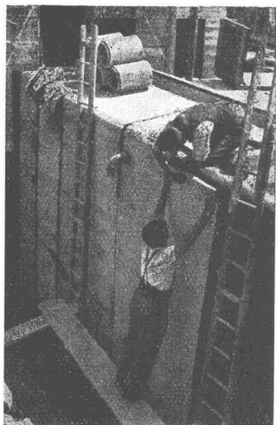
Wand-Isolierung gegen Grundwasser
