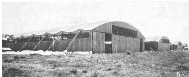
Abb. 13. Flugzeughalle mit Schalenbindern
