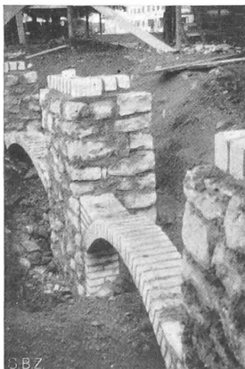
Abb. 4. Fundament Jurakalk, Bögen Kalksandstein in Kalkmörtel
