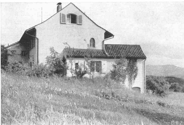
Abb. 8. Nordwestgiebel, Wetterseite des Hauses
