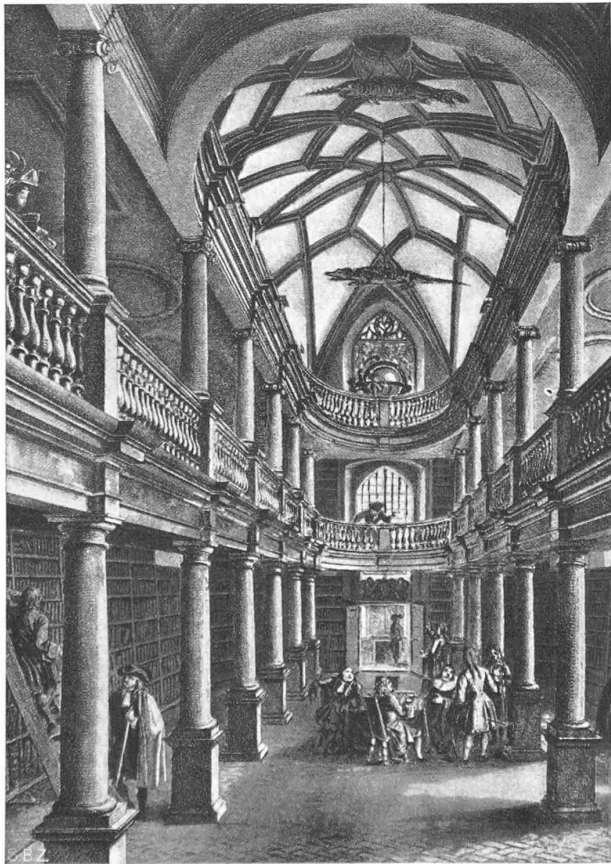
Abb. 11. Galerie-Einbauten der Stadtbibliothek, um 1717
