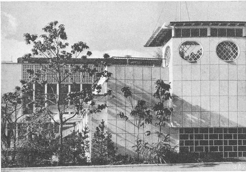
Abb. 21. Ostende des Gartensaalflügels gegen die Claridenstrasse, links im Hintergrund der Kongressaal. Fassadenverkleidung in Travertinplatten, darunter «Glasmauer», nicht Fensteröffnung. Auch die runden, mit unstrukturierter Gitterung gefüllten Oculi des Terrassen-Wandschirms tragen dazu bei, den Charakter des Schweren, aus einzelnen geschichteten Blöcken «Gemauerten» zu vermeiden, und die Wand als gewichtslose, schwebende Scheibe erscheinen zu lassen
