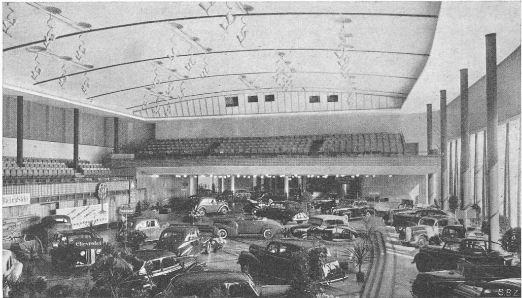
Abb. 33. Kongress-Saal, ohne Bestuhlung für eine Automobilausstellung eingerichtet. Blick gegen Foyer und rückwärtige Galerie, rechts Estrade von drei Stufen, die das «Ausleeren» des Raumes durch die Glaswand etwas eindämmt, wie die analoge Estrade im Konzertfoyer (Abb. 27 und 28)
