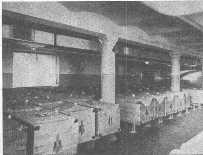
Klimatisierter Tabaklagerraum in einer Zigarettenfabrik
