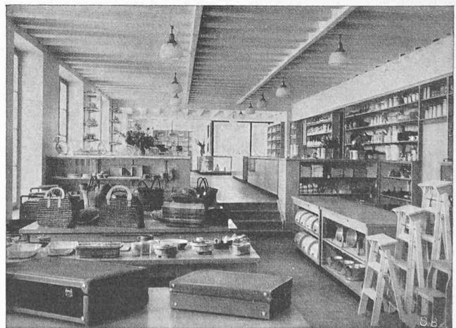
Abb. 17. Haushalt II (mit Holzbalkendecke) gegen Haushalt I
