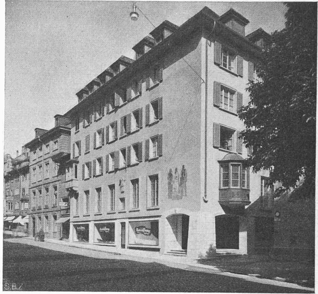
Abb. 2. Erneuerte «Krone» an der Vordergasse, Schaffhausen
